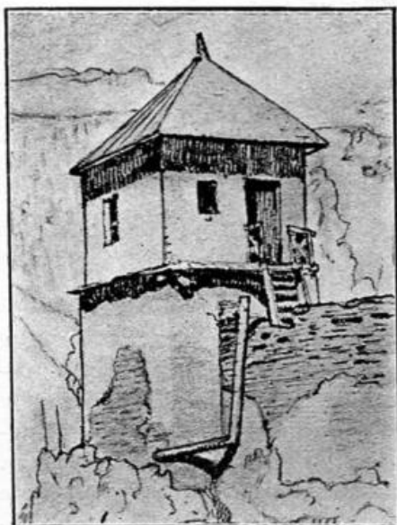
Fig. 326. Mănăstirea Răchitoasa Turn la colț de ziduri.
